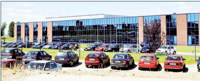
Nowoczesne obiekty firmy Vorverk na ulicy Podgórznej. Powstały na miejscu niedokończonych w PRL, olbrzymiej mleczarni, której tereny miasto przejęło i przygotowało pod inwestycje
