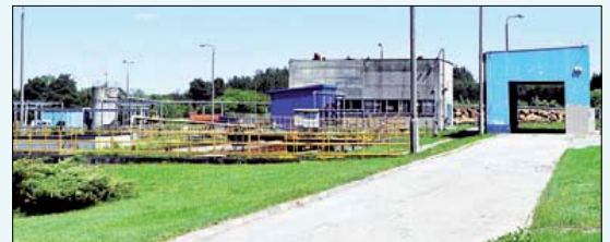
Oczyszczalnia ścieków na Ustroniu. To jednak z pierwszych miejskich inwestycji samorządu miasta Brodnicy po zmianach demokratycznych w naszym kraju
