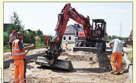
Prace przy ulicy Norwida i Kasprowicza posuwają się w dobrym tempie
