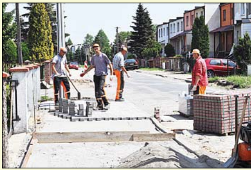
Wymiana krawężników przy ulicy Korczaka
