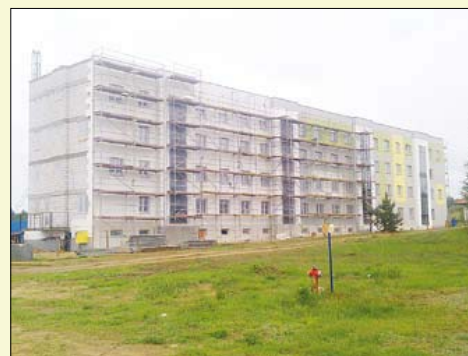
Nowo powstający dom budowany przez Spółdzielnię Kom-Bud w dzielnicy Grunwald
