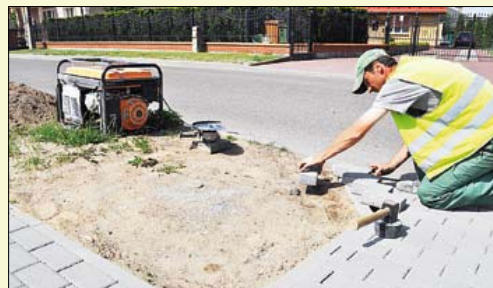
Budowa chodnika przy ul. Reymonta już trwa
