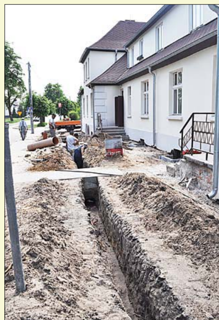
Prace ziemne prowadzone przy Belwederze
