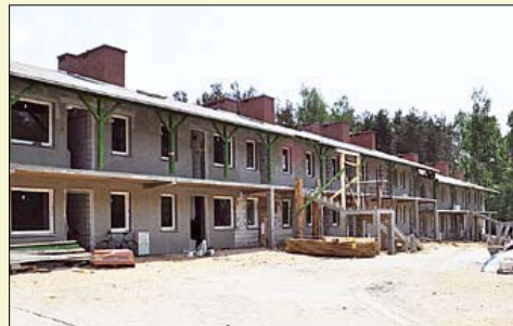
Budowa kolejnego domu socjalnego na osiedlu przy ul. Sikorskiego
