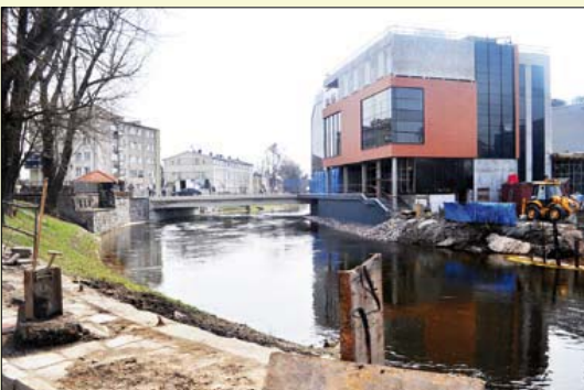
Gotowy do osadzenia nowej kładki przyczółek w sąsiedztwie galerii
