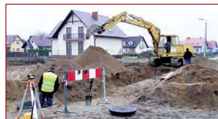
Budowa kanalizacji na osiedlu Ustronie
