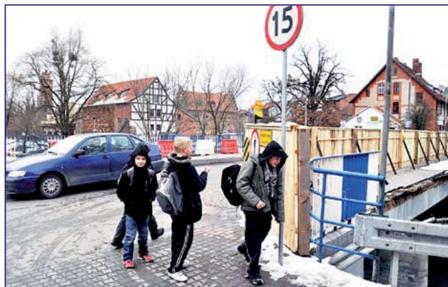
Drewniana ściana zabezpieczać będzie tę stronę mostu do chwili, aż pojawi się ponownie metalowa bariera. Zamontowano także znak ograniczenia prędkości.
