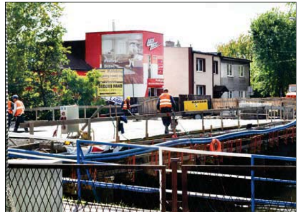
Roboty na moście są również zaawansowane
