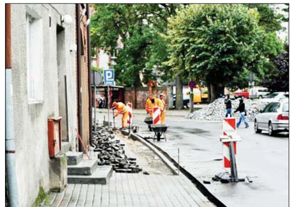
Prace na ulicy św. Jakuba
