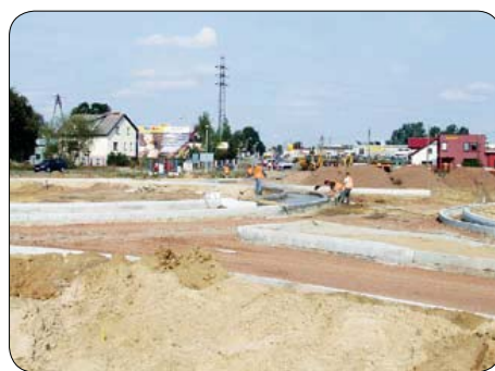
Budowa ronda 11 września 2009
