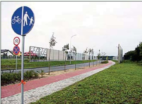
Odcinek nowej drogi z ul. Podgórznej do Ustronia
